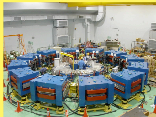
建設中の陽子150 MeV FFAG加速器
